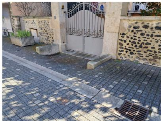
Entrée basse avec murets de soutènement
