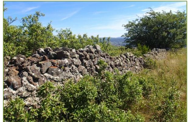
**Figure 122 - A gauche : Murs de pierres sèches supportant une parcelle de prairie de fauche – « La Girette » (36) ; à droite : Muret de pierres sèches délabré – « Mont Ronzon» (37)**
