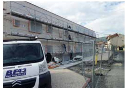
A l'extérieur pendant qu'une entreprise travaille sur la pose d'un bandeau décoratif, une autre entreprend l'enduit sur les façades, tout cela grâce à la coordination inscrite dans le planning.
