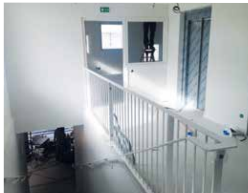
A l'intérieur les différentes salles sont presque terminées. Il reste encore à mettre en service chauffage, luminaires et toilettes.
