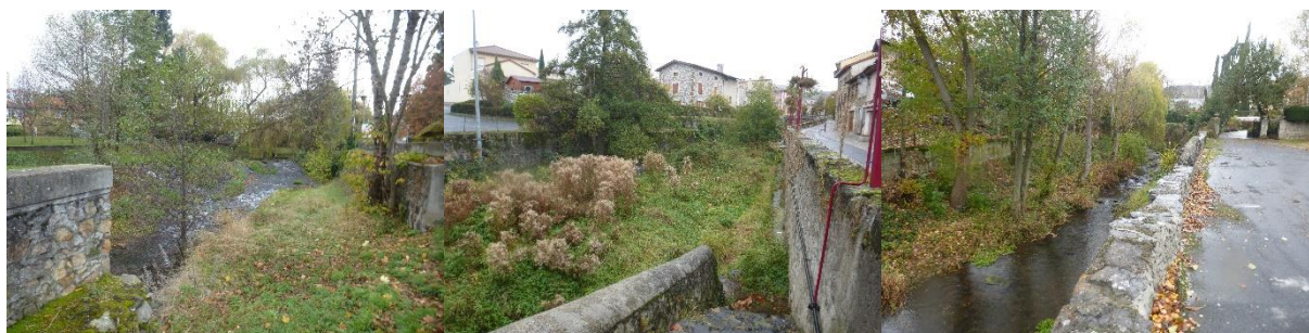
Figure 66 – Abords du Dolaizon, du Nord-est à l’Ouest (Eco-Stratégie, 10/11/2016)
