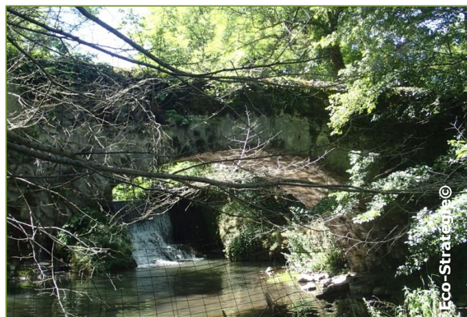
Figure 119 - Pont traversant le Dolaizon - « les Vigneaux » (33)
